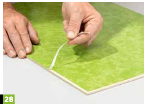
26 Legen Sie die filigranen Folien auf, richten Sie sie aus und kleben sie behutsam fest.
